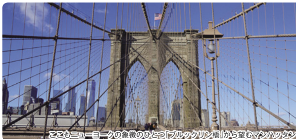
ここもニューヨークの象徴のひとつ「ブルックリン橋」から望むマンハッタン
